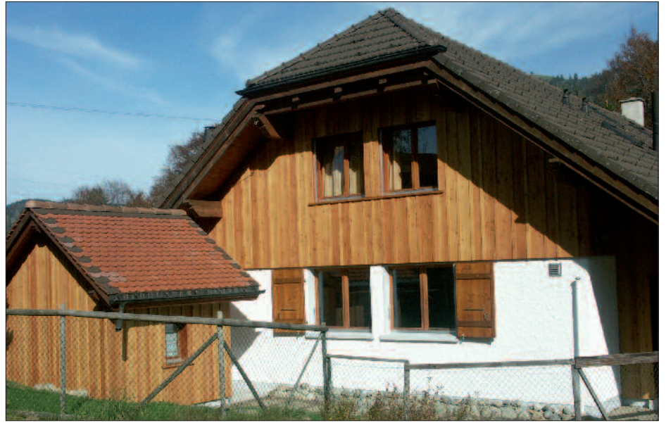
Lames mélèze traitées industriellement avec un saturateur incolore.
