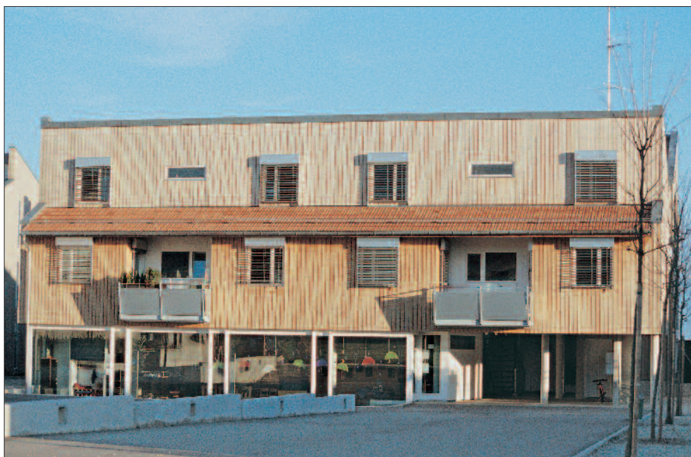
Façade en lames autoclavées non imprégnées.
