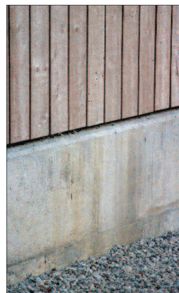
Délèvement des sels de surface sur la maçonnerie.
