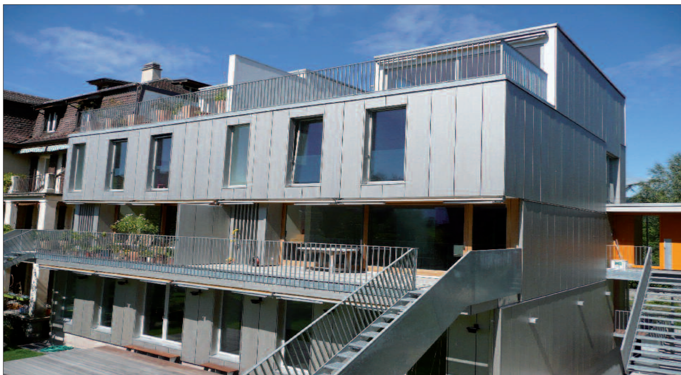
Façade en panneaux massifs épicéa peint avec un glacis à l'eau à base d'allyde, teinte argent métallisé.
