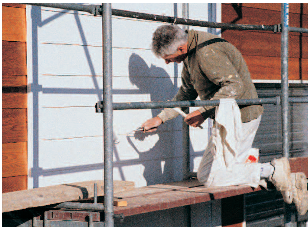
Application au pinceau sur le chantier.
