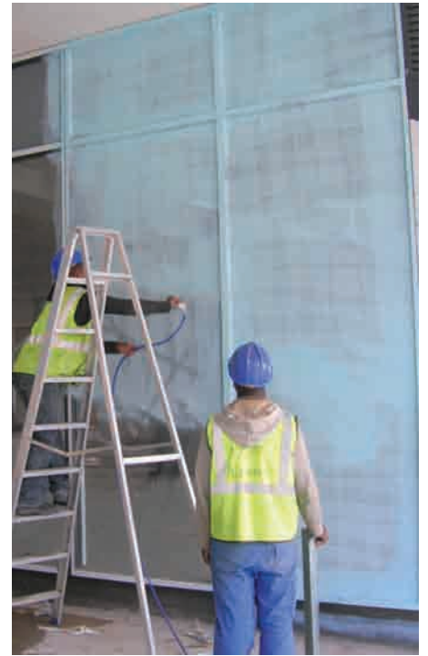
... ont été giclées au Glasstrip Original Super-UV. ... wurden mit au Glasstrip Original Super-UV behandelt.
