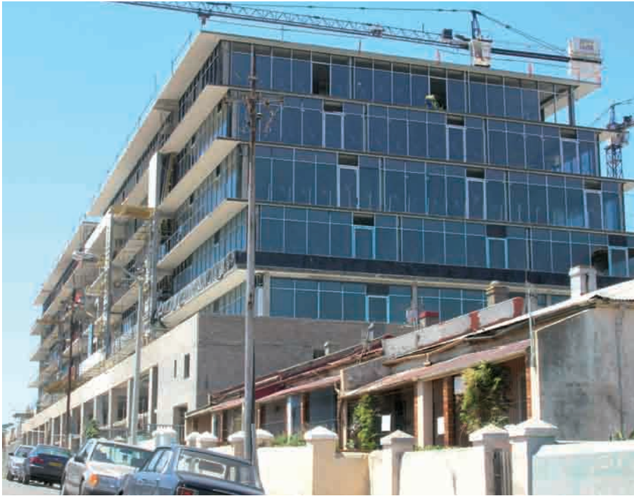
La totalité des fenêtres de ce bâtiment... Alle Fenster dieses Gebäudes...
