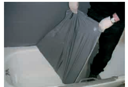
Protection des appareils sanitaires pendant la durée du chantier.
