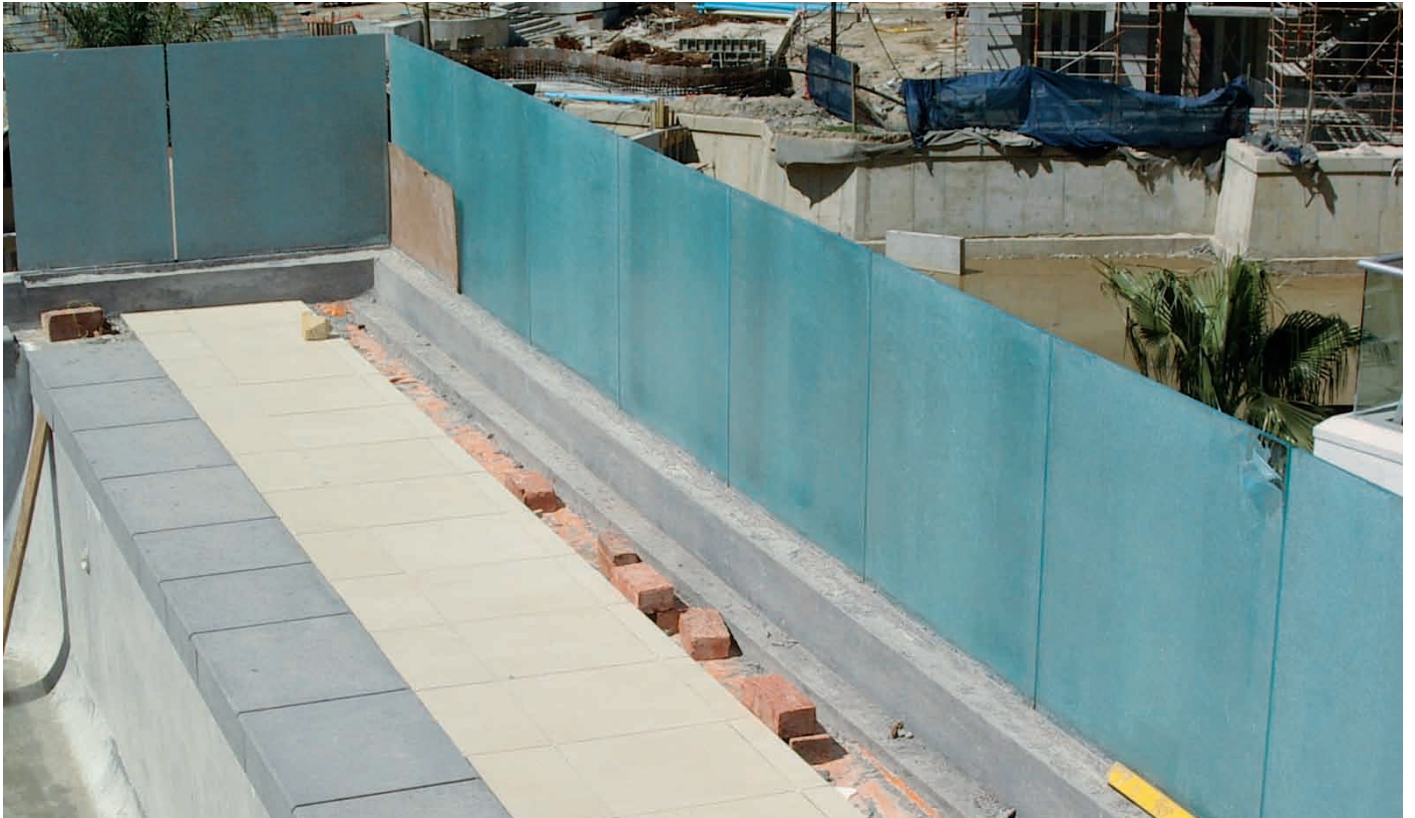
Barrière de balcon en verre protégée avec du Glasstrip Original. Balkongeländer aus Glas geschützt mit Glasstrip Original.
