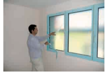
Protection des fenêtres finies pendant la durée du chantier.
