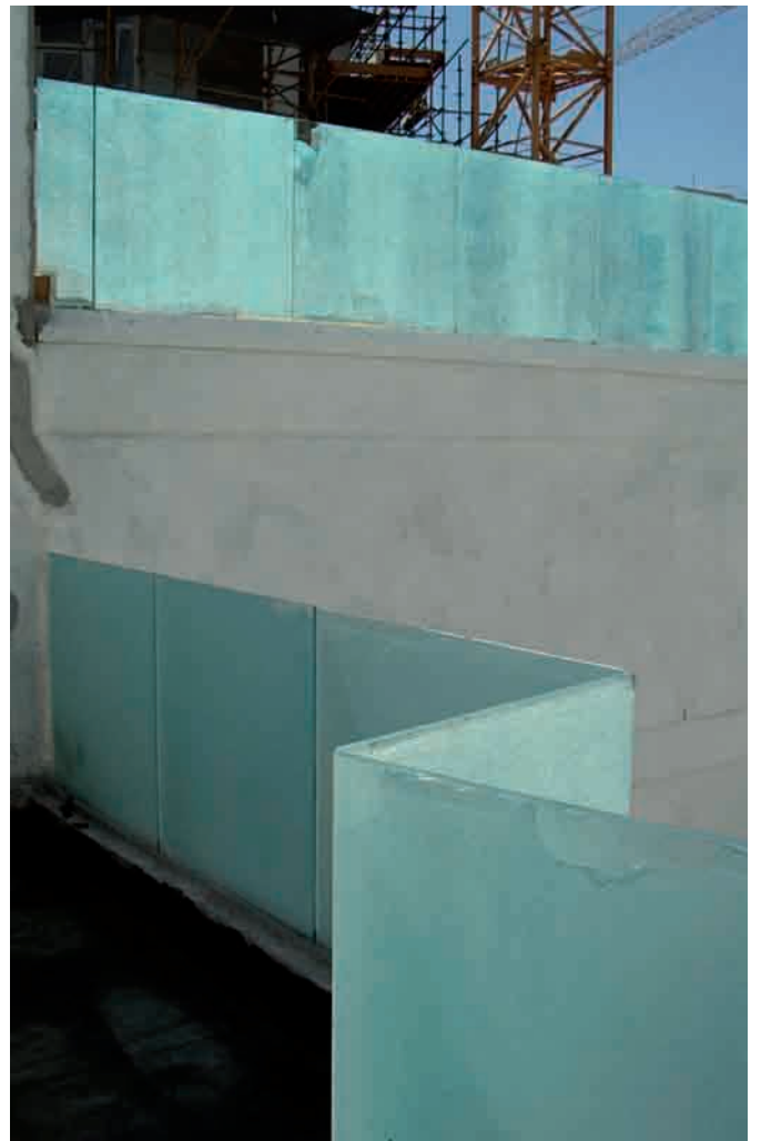
Barrière de balcon en verre protégée avec du Glasstrip Original. Balkongeländer aus Glas geschützt mit Glasstrip Original.
