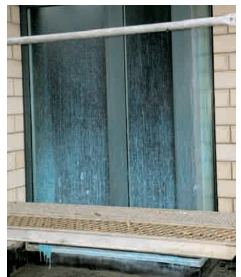
Le Glasstrip Original se délave s'il pleut dans les 24 heures après son application.
