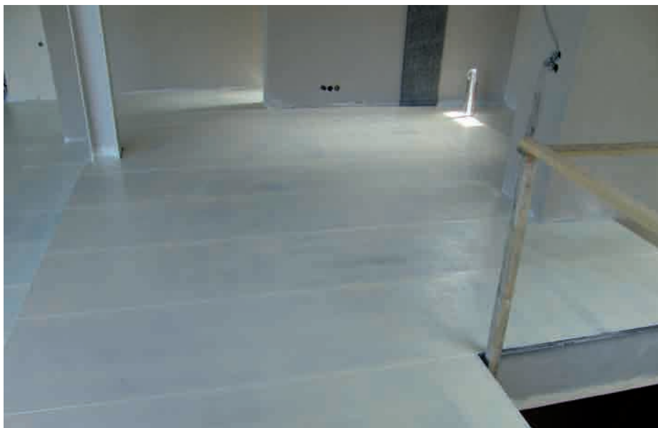
Le sol intérieur est également protégé au Deckstrip.
