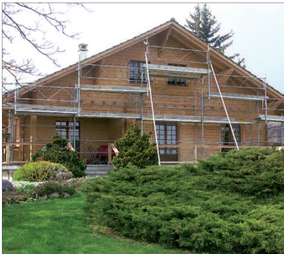
... ou lors d'une rénovation complète.
