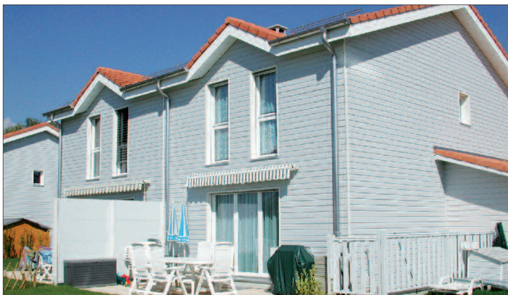
Les façades traitées avec des systèmes à longue durée, tels que peintures couvrantes...
