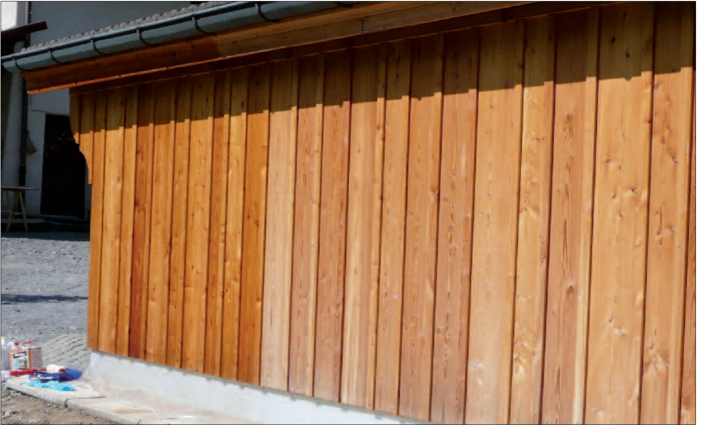
L'entretien d'un saturateur incolore se fait sans préparation de fond et ravive le bois blanchi.
