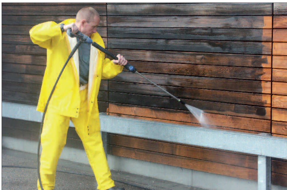
Le dégrisaillement du bois au Net-Trol permet de repartir sur un support neuf et sain.
