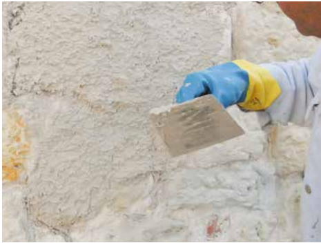
Talocher le mortier de giclage
