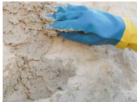
Jointoyage avec GREOSAN Enduit de fond 0–6 mm
