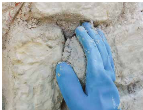
Jointoyer avec GREOSAN Hydroment LP (à la main)
