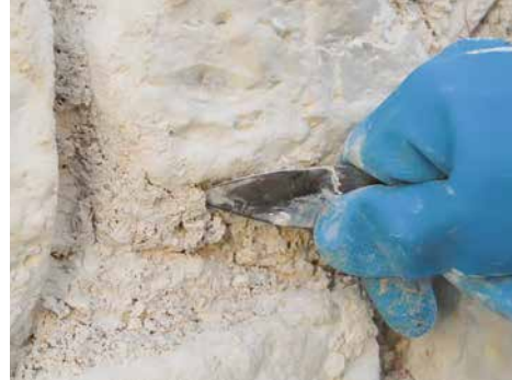
Grattage du mortier dans les joints
