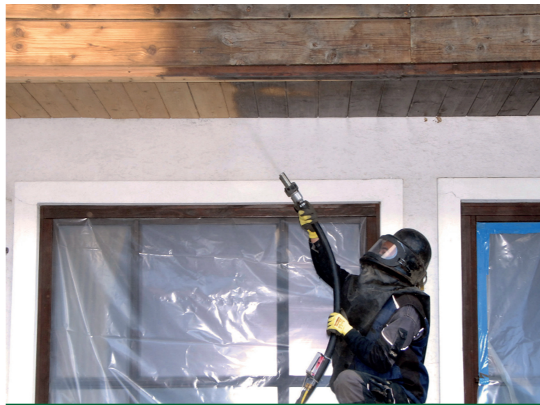
2. Les anciennes couches de peintures sont rapidement éliminées par sablage, sans agent chimique.
