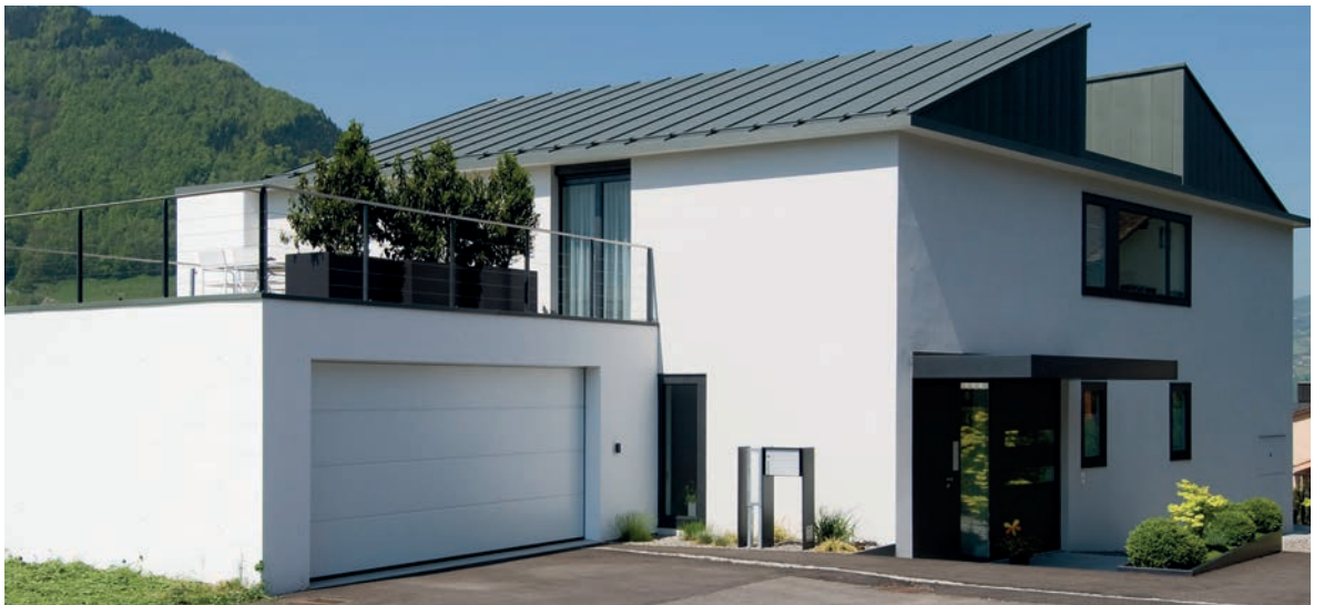
Immeuble d'habitation certifié Minergie à Schwyz, surface: 480 m 2 . Structure du système: isolation avec EPS Lambda light 180 mm, couche de fond Pura Mortier d'enrobage 426, enrobage des voiles Pura Mortier d'enrobage 426, couche de finition Pura Ribage précieux 402 plein, 2 mm et 0,5 mm, peinture Peinture silicate bi-composant.
