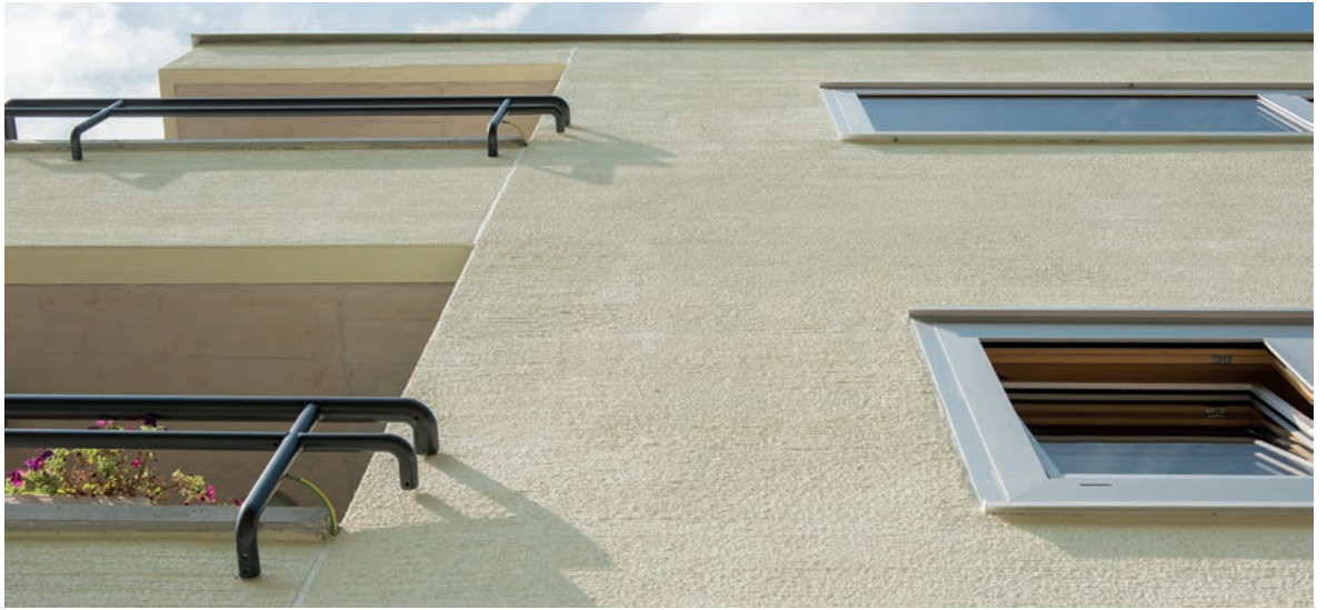
Établissement médico-social à Dornach, surface: 650 m 2 . Structure du système: isolation à la laine de pierre, 200 mm, couche de fond Pura Mortier d'enrobage 426, enrobage des voiles Pura Mortier d'enrobage 426, couche de finition Pura Ribage précieux 402 plein, 2 mm, peinture Pura Peinture silicate.
