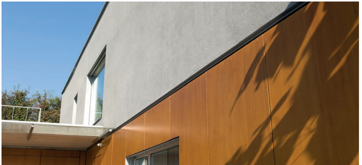
Immeuble d'habitation à Küsnacht, surface: 370 m 2 . Structure du système: isolation avec panneaux lamellaires en laine de pierre, 160 mm, couche de fond Greutol Mortier d'enrobage light 425, enrobage des voiles Greutol Multiplan 407, couche de finition Greutol Enduit de blanchiment light 590 et Enduit de finition résine silicone 361, 5,0 mm.
