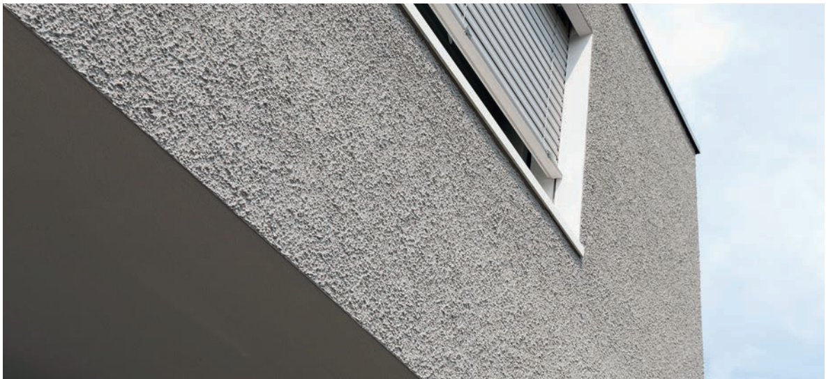
Maison à deux appartements à Fislisbach, surface: 370 m 2 . Structure du système: isolation avec EPS Lambda Plus 180mm, couche de fond Greutol Mortier d'enrobage light 425, enrobage des voiles Greutol Multimortier 406, couche de finition Greutol Crépi à la truelle 300, 6,0mm, peinture GreoColor OptiTop.
