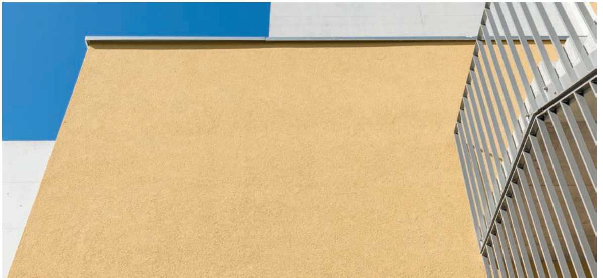
Immeuble d'habitation à Brugg, surface: 4200 m 2 . Structure du système: isolation avec EPS 200 mm, enrobage des voiles Greutol Enduit Combi 488, couche de finition Greutol Ribage précieux 400 extérieur plein 2,0mm, peinture GreoColor OptiSilc.
